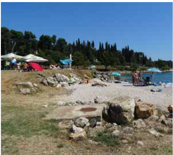
Slika 7: Postojeći ispust na kraju zacijevljenog vodotoka
